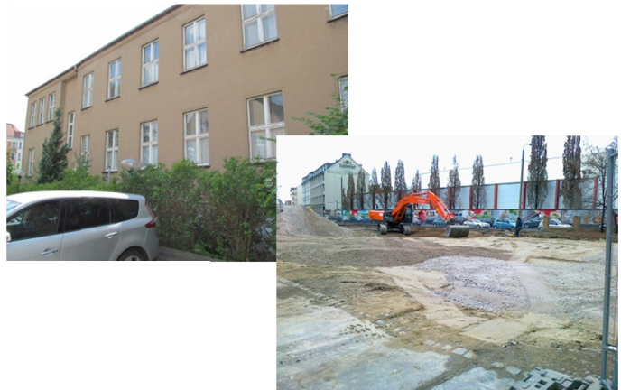
Erste Rückbauarbeiten. Gebäude 5142 vor und nach der Maßnahme
