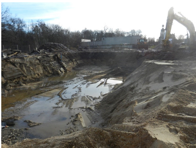
Durchführung des konventionellen Bodenaushubs
