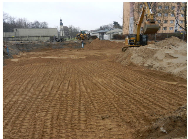
Wiederverfüllung der Baugrube
