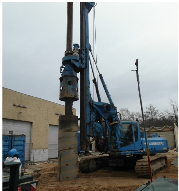
Durchführung der Großlochbohrungen im Hot-Spot-Bereich
