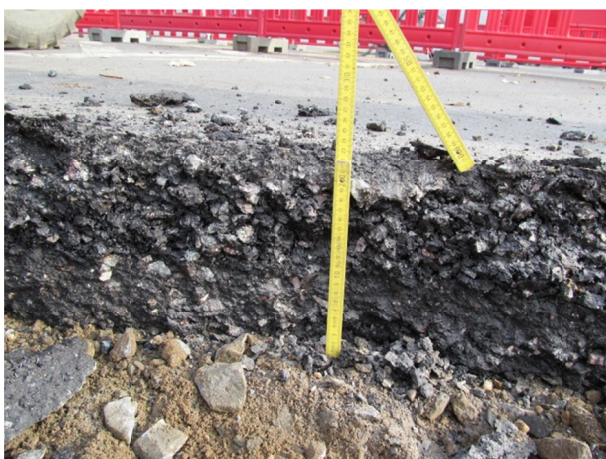
Dokumentation der Mächtigkeiten des zurückgebauten Asphalts für die Plausibilitätsprüfung der Entsorgungsmengen
