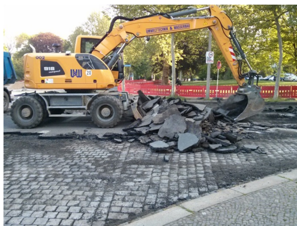
Überwachung und Dokumentation des Rückbaus und der Separierungsarbeiten
