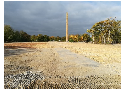
Geländeansicht nach Rückbau der oberirdischen Gebäude
