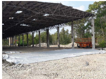
Werkshalle während der laufenden Abbrucharbeiten (Wellasbestdach)
