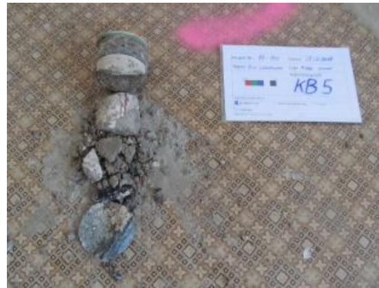
Durchführung von Kernbohrungen zur Erfassung des Fußbodenaufbaus
